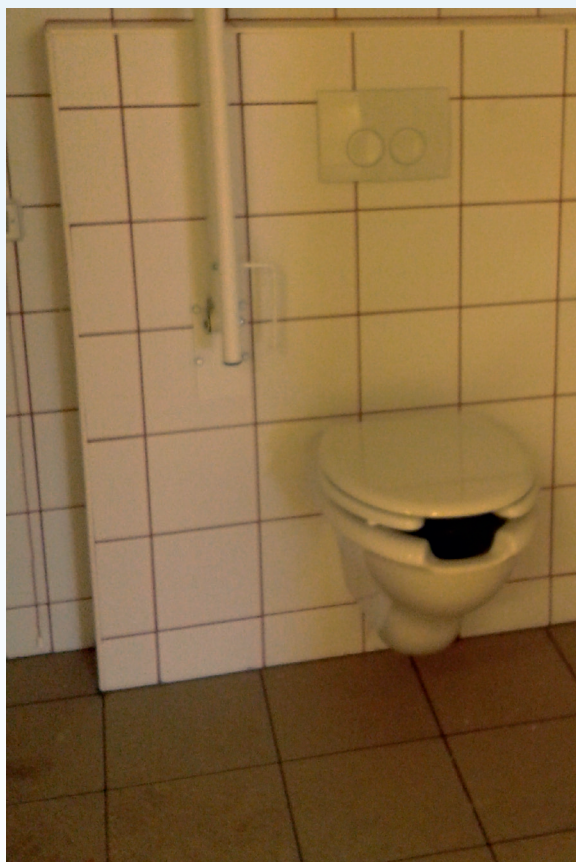
1. ábra: A bal oldali fotón helytelen megoldás (elől nyitott, „rövid” WC széles szerelőfallyal, fehér csempe fehér berendezési tárgyakkal), a jobb oldali fotón megfelelően megválasztott berendezési tárgyak láthatóak.
