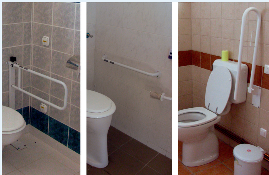
2. ábra: A bal oldali és középső fotón a 22 mm-es, a jobb oldali fotón a megfelelő méretű, 32 mm átmérőjű kapaszkodó látható
