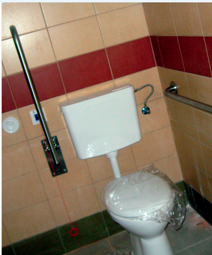
1. ábra: A bal oldali fotón helytelen megoldás (elől nyitott, „rövid” WC széles szerelőfallyal, fehér csempe fehér berendezési tárgyakkal), a jobb oldali fotón megfelelően megválasztott berendezési tárgyak láthatóak.
