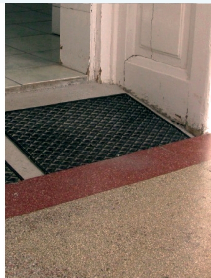
3. ábra: A bal oldali fotón egy műemlék jellegű épület főbejárata, a jobb oldali fotón két helyiség között kialakult minimális szintkülönbség látható. Mindkét esetben a szintkülönbség küszöbrámpa építésével áthidalható, a küszöbrámpa falsíkban kialakítható
