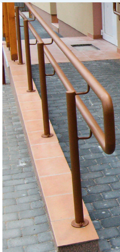
4. ábra: A bal oldali és a középső fotón a markolat helytelen rögzítése, a jobb szélső képen a helyes rögzítési elv, illetve a korlátvégek íves lezárása látható
